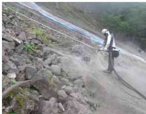
【変更後：連続長繊維補強土工】
