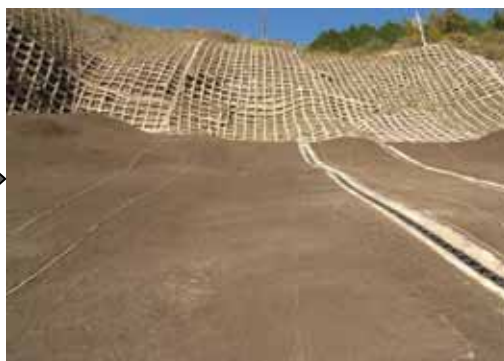
【完了：吹付工・植生工併用】
