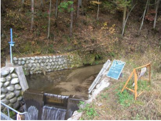
農業用用水取水口浚渫完了
