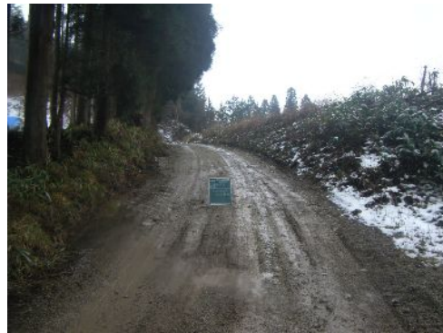
搬入路修繕後
