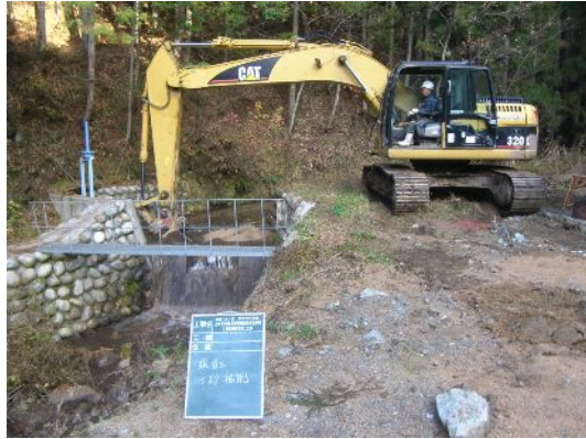
浚渫工事施工状況
