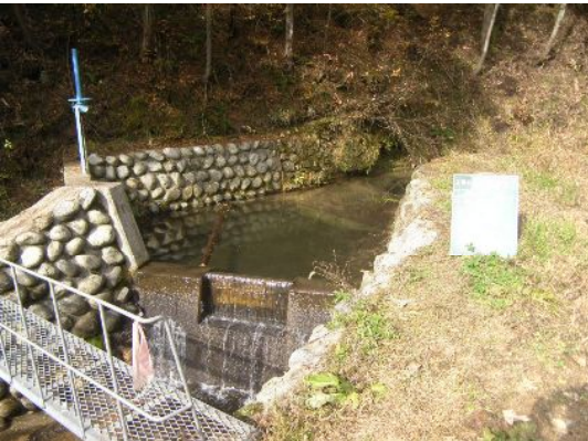
農業用用水取水口浚渫完了
