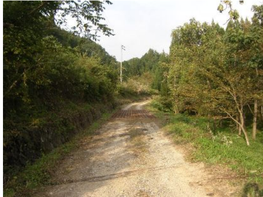
除草及び整地完了
