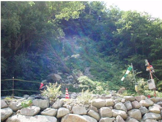
図 5 溪岸部の崩壊
