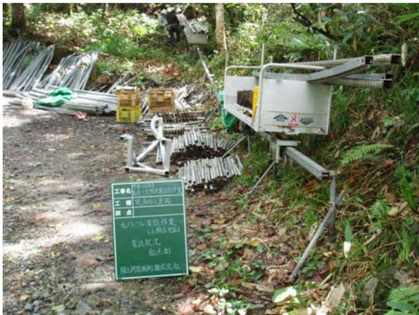
図 12 モノレール架設状況（起点）
