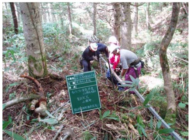
図 13 モノレール架設状況
