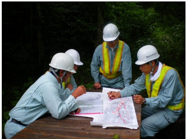
〈 現場作業前の安全確認ミーティング 〉
