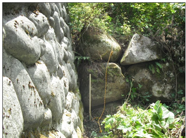
＜ 護岸登攀用ロープ設置状況 ＞
