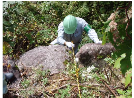
写真-3 トラロープによる補助
