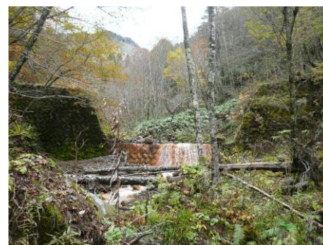
昭和初期の砂防堰堤（岩坪谷第3号）
