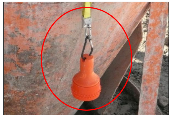
(コンクリートバケットに取付けた吊荷警報機)
