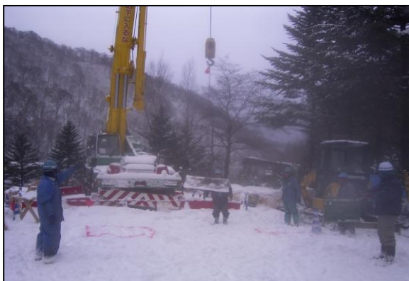
(クレーン合図実地訓練)
