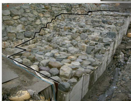
完成床固工(垂直壁・魚道・本堤)
