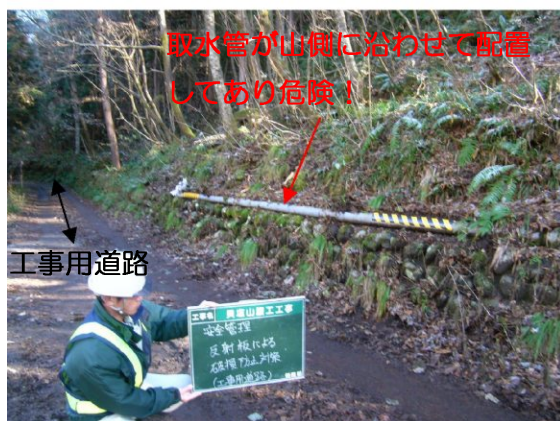
【取水管配置状況】
