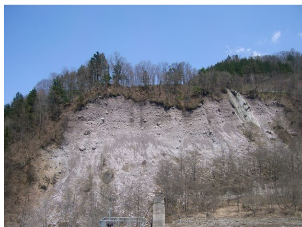
【平成 20 年 4 月 着手前】
