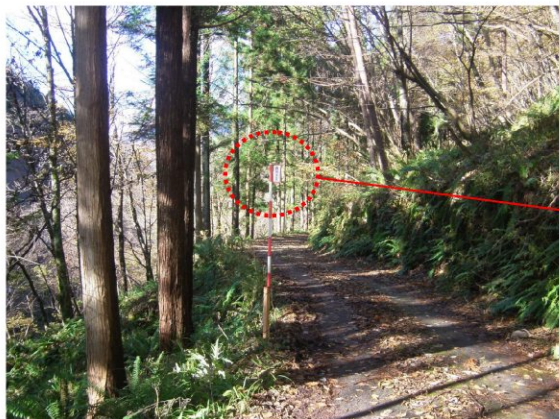
【路肩注意標識ポールの設置状況】
