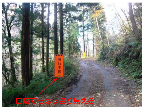
【高輝度安全看板設置状況】
