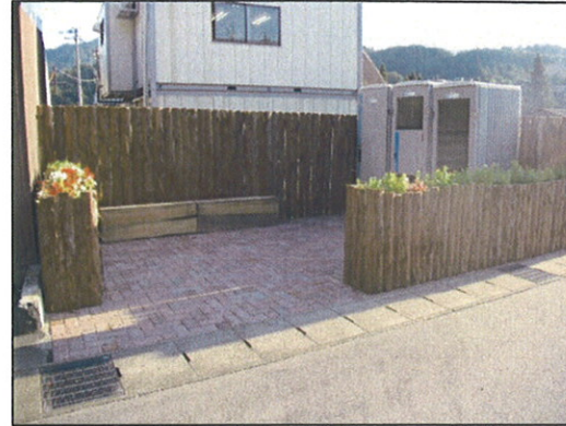
インターロッキング舗装による整備
