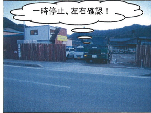
ダンプトラックの使用状況
