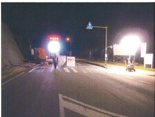
国道 471 号線の夜間通行止め
