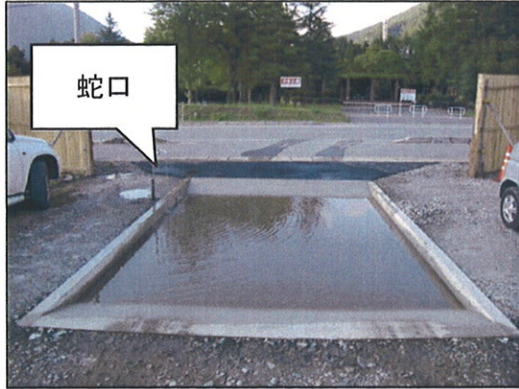
着工前に洗車場を施工
