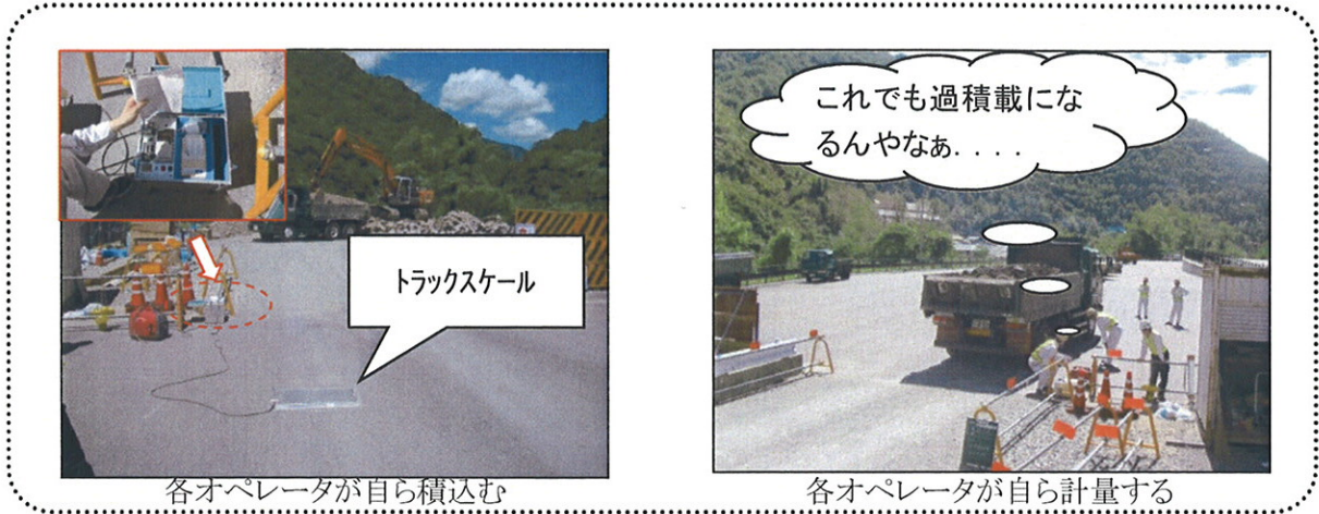
写真-4 トラックスケールによる過積載防止訓練
