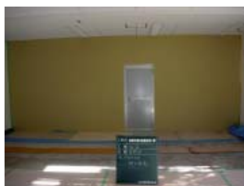
仮間仕切設置
