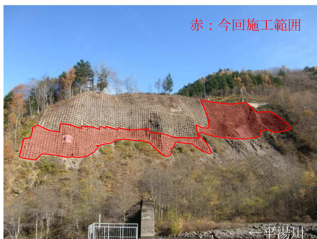
写真-1 工事箇所全景 (完成時)
