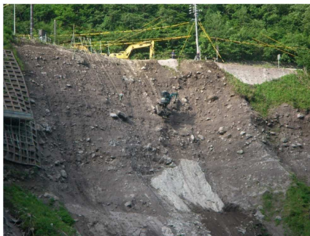
写真-2 RCM 施工状況
