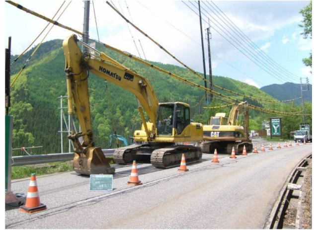
写真-3 移動式重機アンカー設置状況
