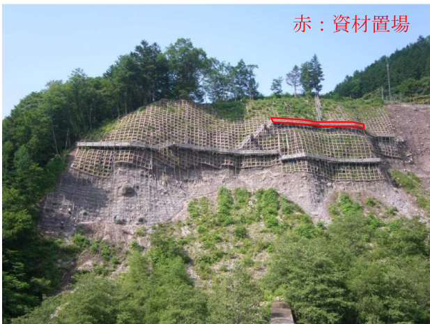
写真-9 仮設通路、資材置場設置状況
