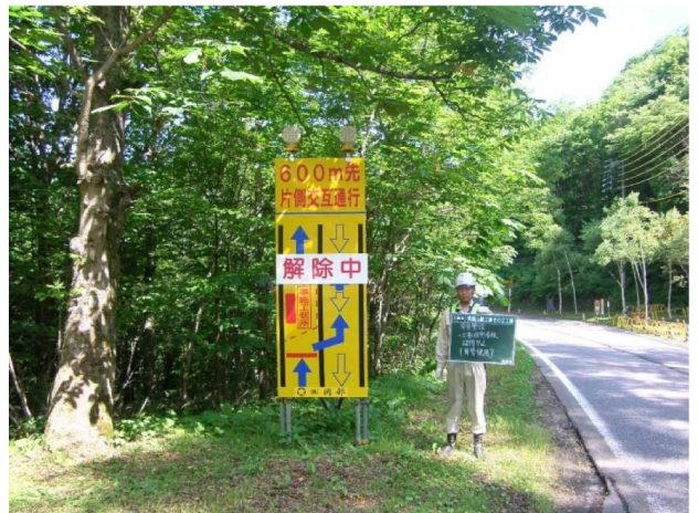
写真-4 大型規制予告看板
