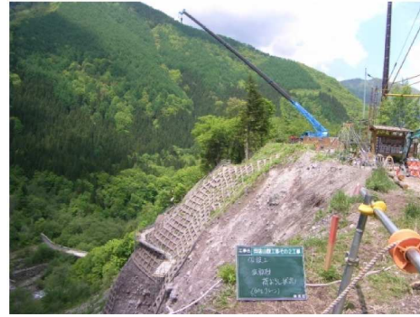
写真-10 クレーンによる一次運搬状況
