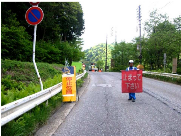
写真-5 交通誘導状況
