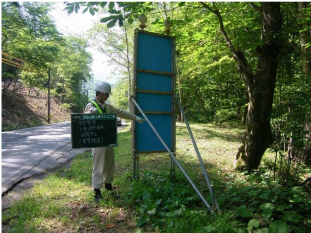
写真-5 単管控え設置状況
