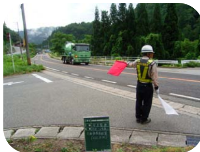
※交通誘導員配置状況※
