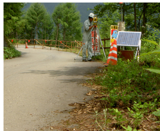
定点測量状況
