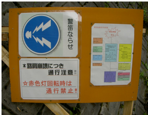
連絡先看板等（上下流ともに設置）
