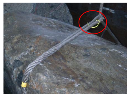
巨石吊り込み状況
