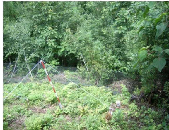
(下部落石防護ネットの設置)
