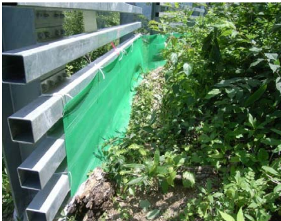
(下部落石防護ネットの設置)
