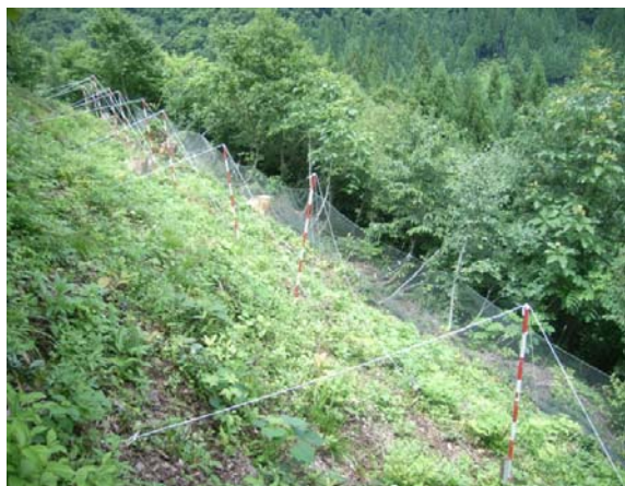
(下部落石防護ネットの設置)
