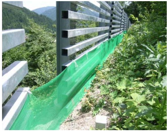
(下部落石防護ネットの設置)
