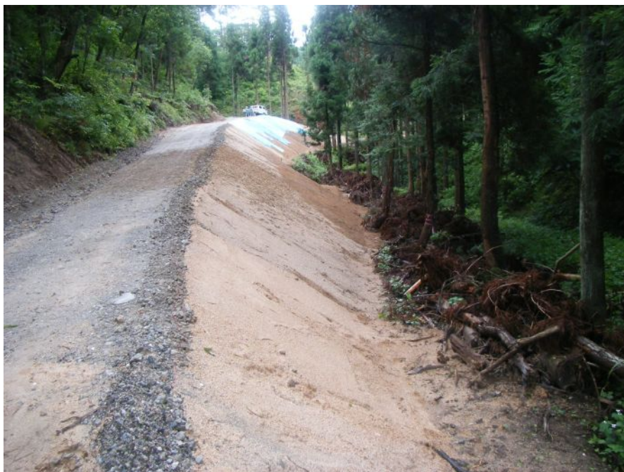
路面に碎石を敷き均しスリップ防止
