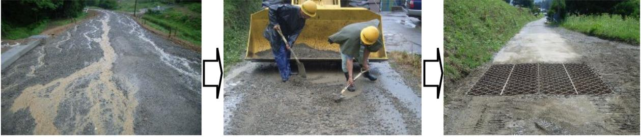
急勾配による取付道路の土砂流出、土砂除去後に下流域への土砂流出を考慮して格子状のロードマットを敷き大量流出防止の効果は出ました。
