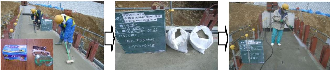
ワイヤーブラシによる表面処理    コンクリート粉塵収集処理(環境配慮)    圧力水での洗浄
