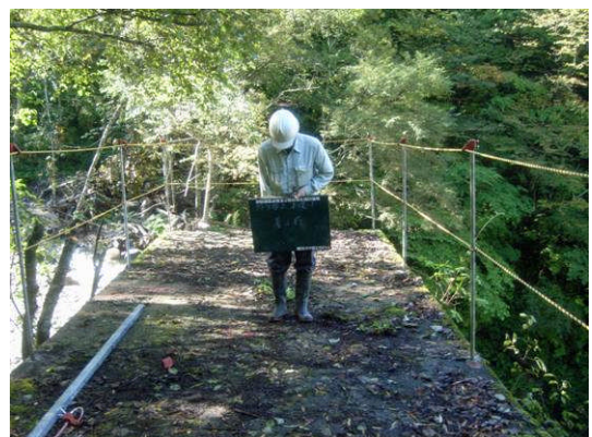
写真2 転落防止柵設置状況
