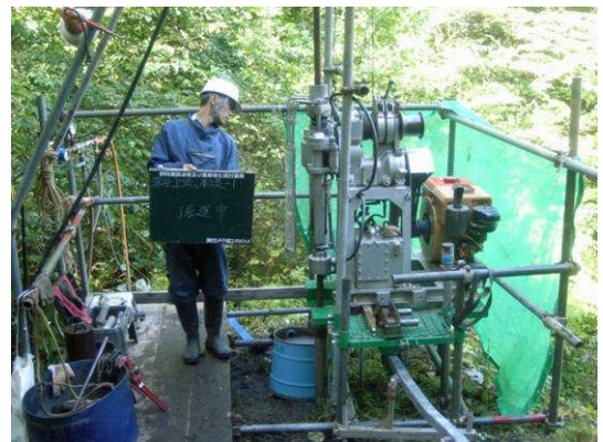
写真4 実際の掘進作業状況
