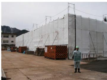
コンクリート打設～採暖養生中外部足場
