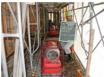
加熱養生用ヒーター設置状況
