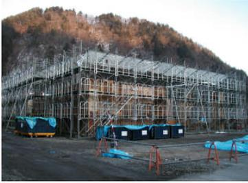
配筋・型枠工事施工中の外部足場形状
