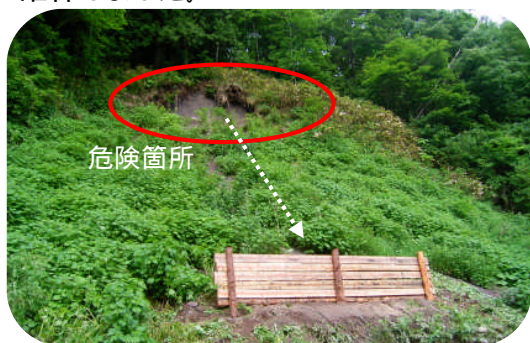
落石防護柵設置状況
