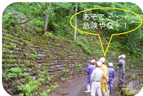
工事着手前の総点検実施状況
