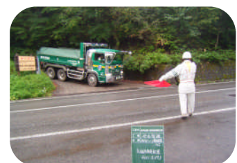
交通誘導員配置状況
