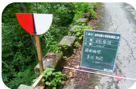
路側簡易変位計設置状況
