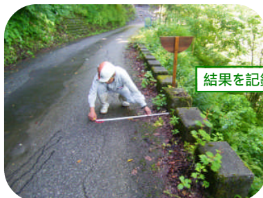
日常点検状況
