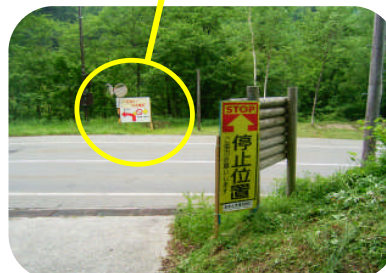
工事関係者に対する注意喚起看板
