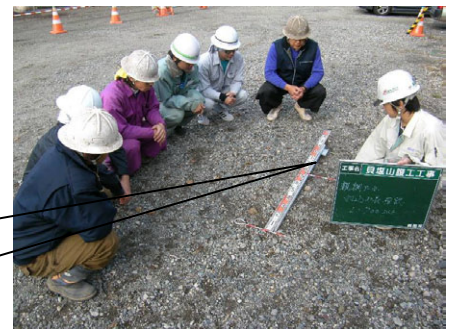
写真-7 親綱アンカー確認
