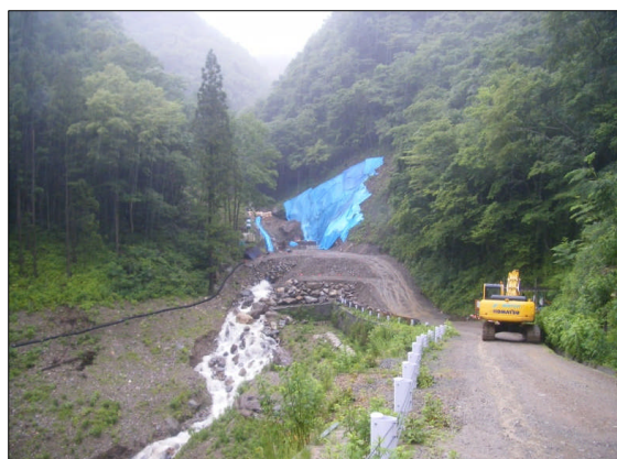
平成21年7月8日状況（現場）
