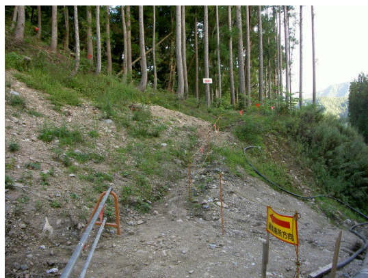
副堰堤下流避難場所
