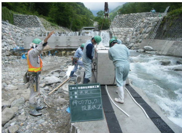
締切ブロック設置状況
