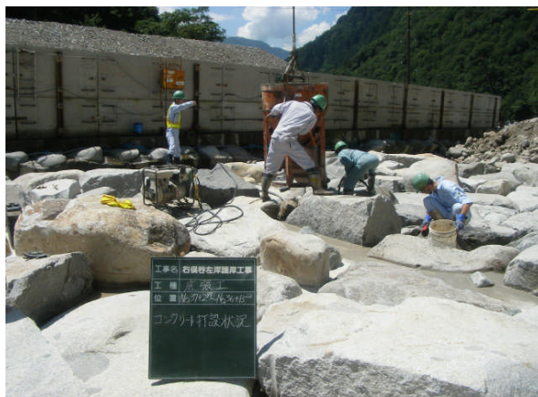
コンクリート打設状況
