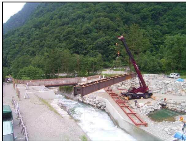
【桁の架設状況】
