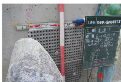
巨石設置状況 巨石φ0.5～0.7程度 2/3埋込み
