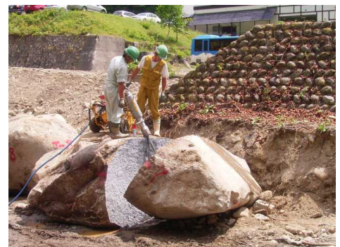
写真-3 人力による転石破碎
