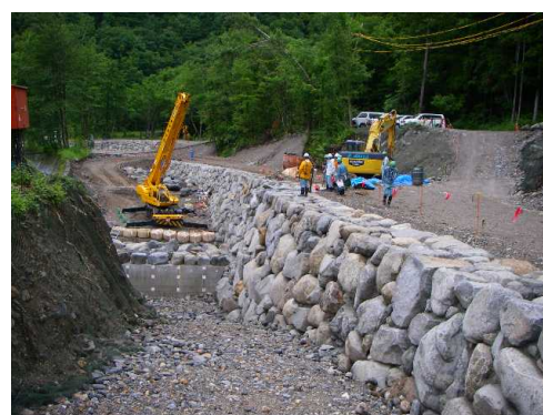
写真-4 低水護岸の巨石積み
