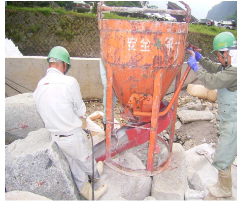
コンクリート打設状況
