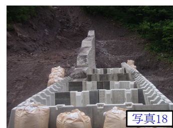
〔内部型枠設置〕
