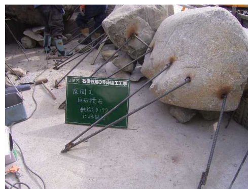
写真-5 鉄筋による巨石の固定
