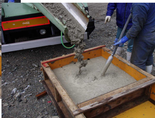
生コンクリート 打設状況
