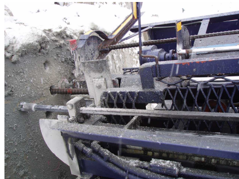
鉄筋挿入状況
