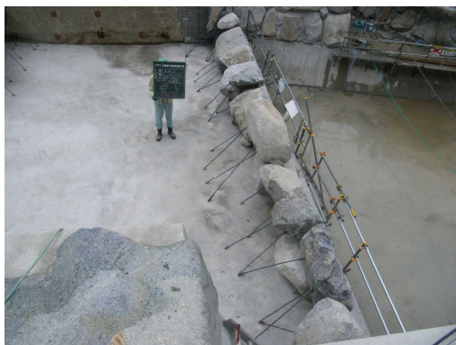
本堤巨石積み完了（打設前）
