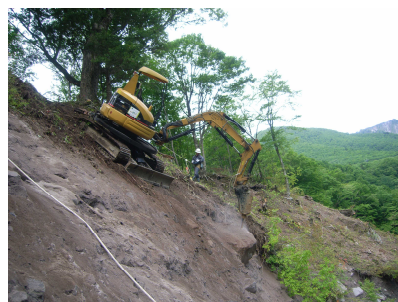
写真-3 ブレーカー掘削状況
