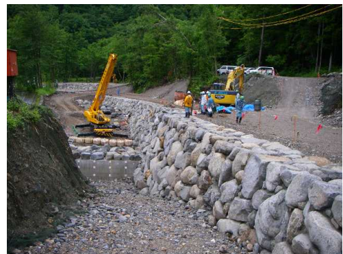
写真-4 低水護岸の巨石積み
