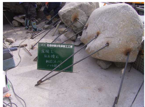
写真-5 鉄筋による巨石の固定
