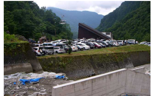
写真-13 護岸施工予定箇所の満車の駐車場 (8月)
