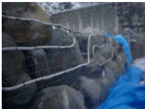
写真-8 温泉を引いた冬期養生
