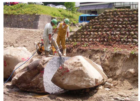
写真-3 人力による転石破碎
