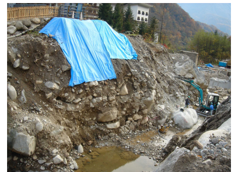
写真-2 転石多く掘削進まず (H19 工事)
