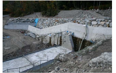
写真-12 費用がかさむ締切 Con 壁 (右俣3床)
