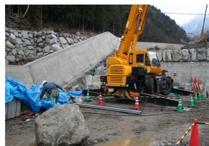
(敷鉄板と安全コーンの設置)
