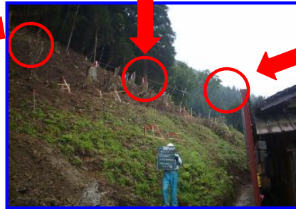
【仮設防護柵(B)】
