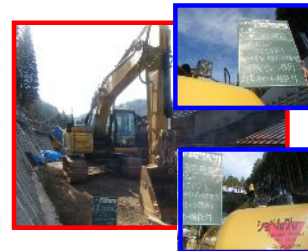
【取付機械 BH0.45m³】
