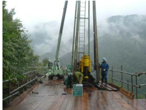
(カニクレーン作業状況)
