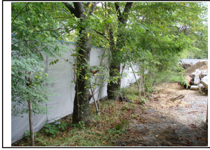
粉塵飛散防止メッシュシート張 ⑦
