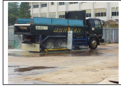
公道汚染防止のタイヤ洗淨機の設置 ⑧
