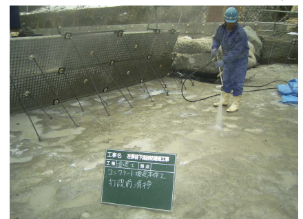
【ボイラー温水清掃・湿潤】
