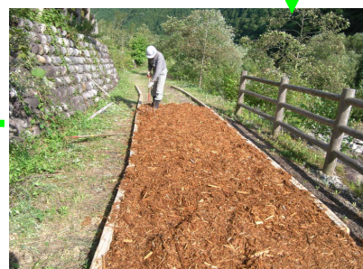
【型枠設置・敷均し】
