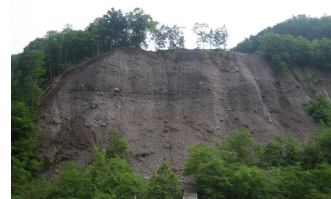
掘削、法面整形完了
