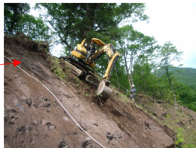
写真-2 掘削状況
