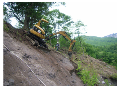
写真-3 ブレーカー掘削状況
