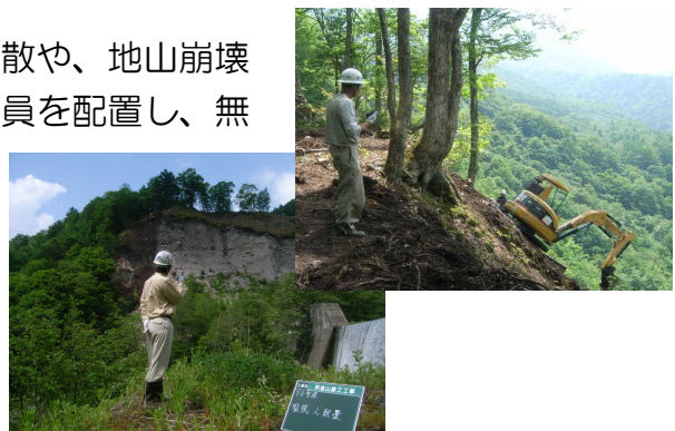
写真-5 監視員配置
