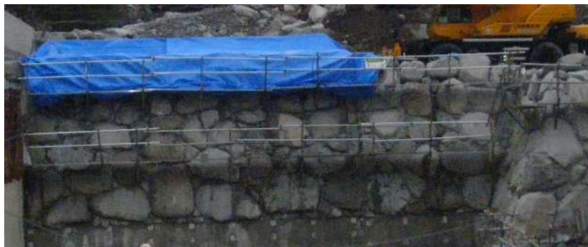
※巨石積み状況・・・本堤下流側より
