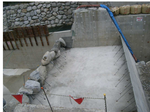
本堤巨石積み・残存型枠組立完了（打設前）
