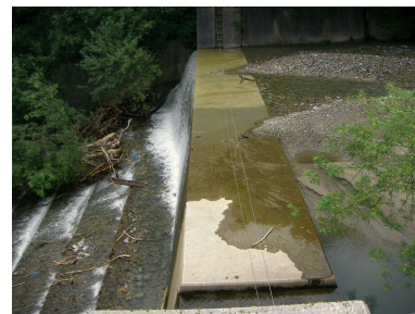
2.小鍋1号堰堤 水通し部設置
