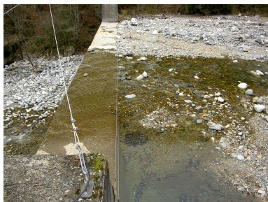
1.右俣2号堰堤 水通し部設置（現場 約700m上流）
