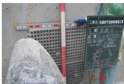
巨石設置状況 巨石φ0.5~0.7程度 2/3埋込み
