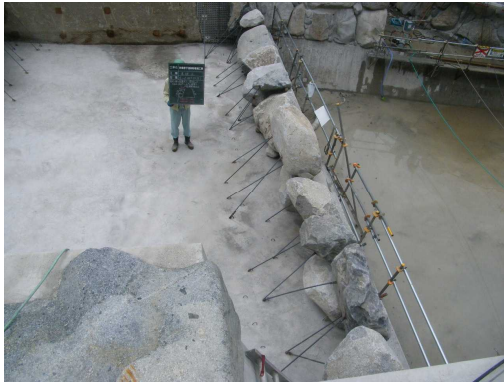
本堤巨石積み完了（打設前）
