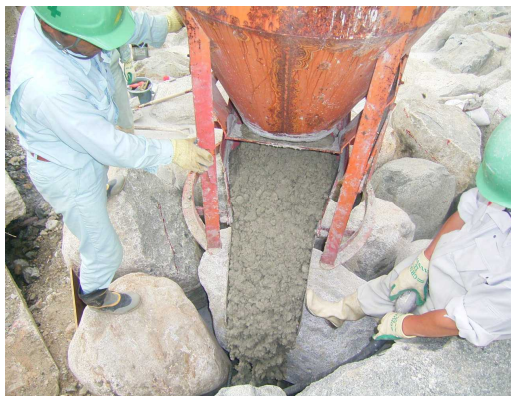
コンクリート打設状況
