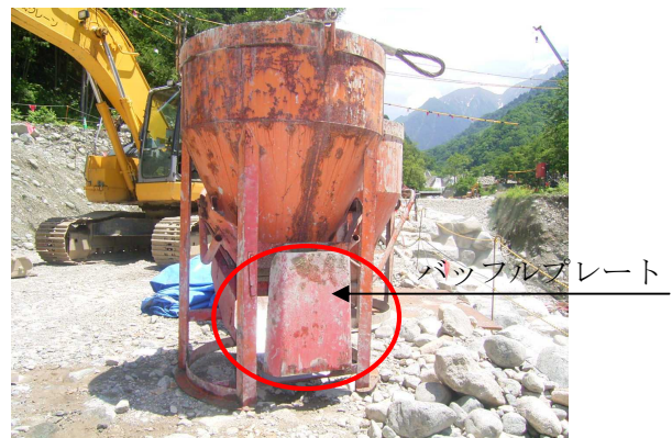
バケットの改良後
