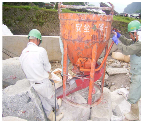
コンクリート打設状況
