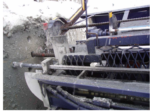
鉄筋挿入状況
