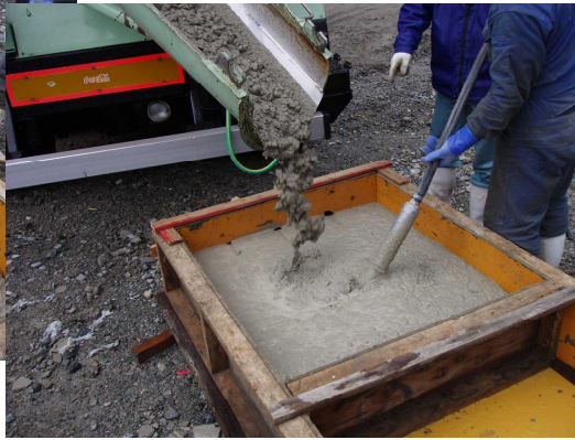
生コンクリート 打設状況
