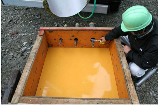
型枠組立 状況
