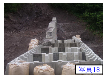
[内部型枠設置]
