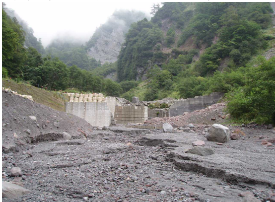
〔平成19年度 着工前〕
