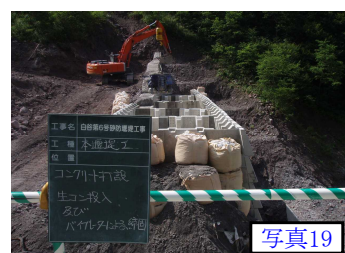
[生コン打設状況]
