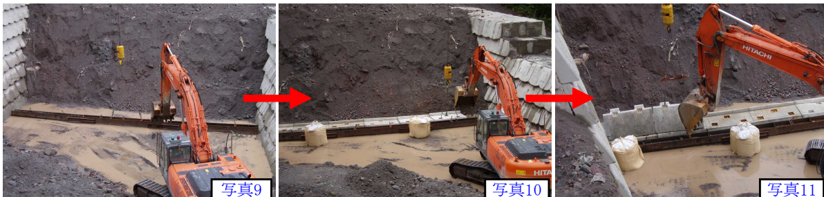
〔H形鋼据付〕
