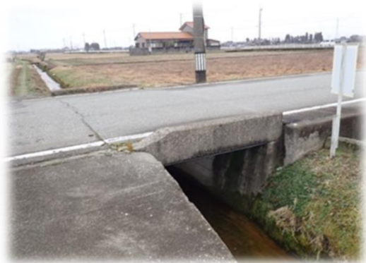
断面欠損部(補修部)
