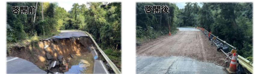
道路啓開作業状況(県道28号 大谷狼煙飯田線 珠洲市三崎町寺家)
