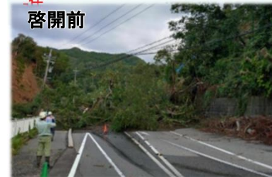
道路啓開作業状況(国道249号 輪島市深見町)
