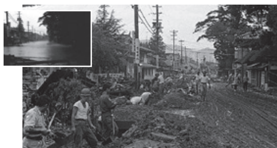
■道路冠水後大量の土砂が残された渡邊邸前
