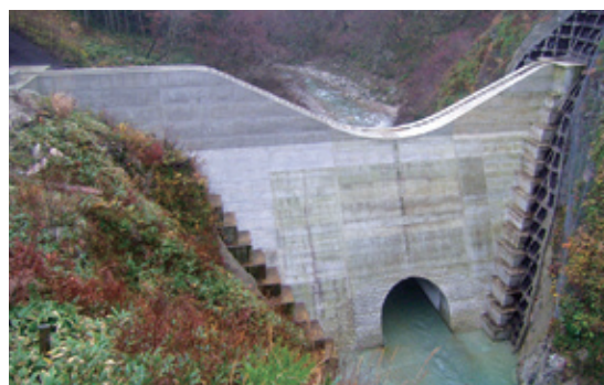
女川第4号砂防堰堤
