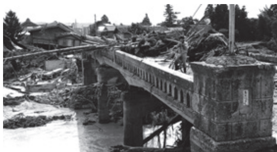
■流木の山となった小国大橋
