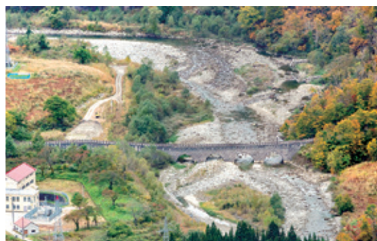
玉川スーパー暗渠砂防堰堤
