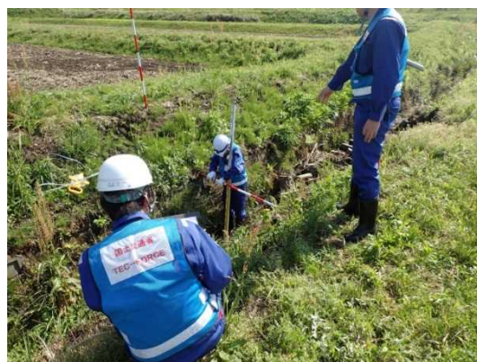
河川施設状況調査
