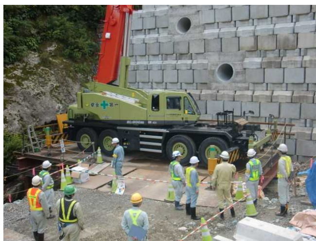
中ノ俣川砂防堰堤工事
