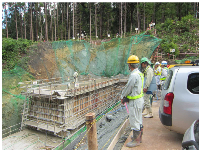
足水川上流砂防堰堤工事
