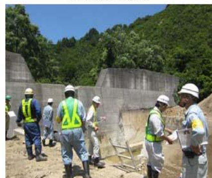
【川入工区 工事現場】
