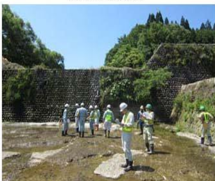
【足水川工事現場】
