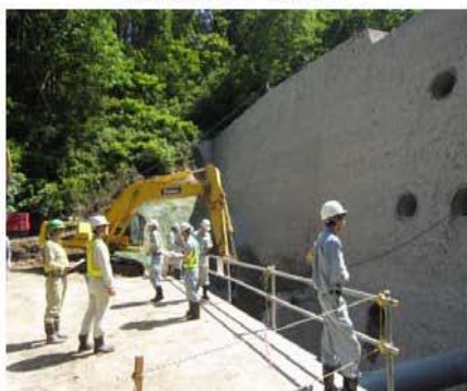
【沢のり沢工区 工事現場】
