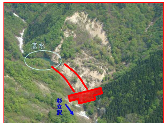
河道閉塞発生箇所
