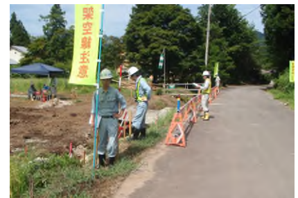
安全点検状況 2
