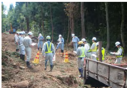
工事現場の説明
