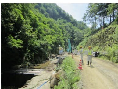
③ 安全点検状況
