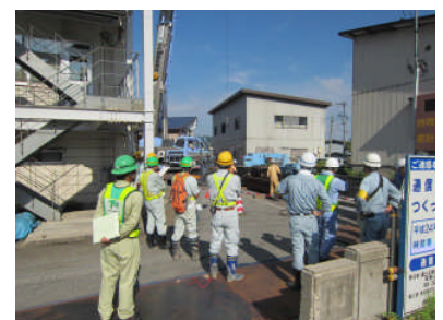
⑦ 安全点検状況
