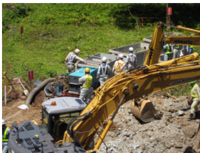
五味沢地区砂防堰堤 [寺ノ裏沢]
