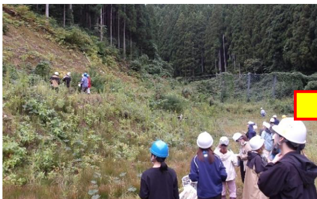
法面崩壊状況の確認（下土沢砂防堰堤）
