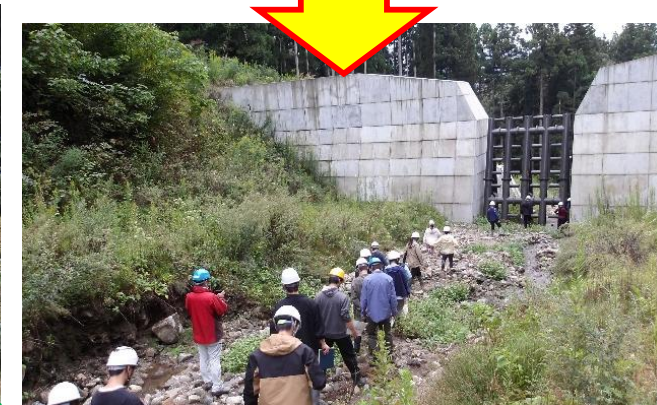
鋼製スリットを間近で見学！
