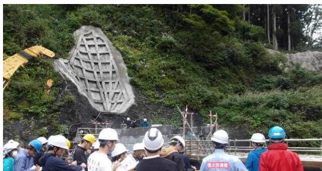
工事施工状況の説明 （藤沢川第3号砂防堰堤）
