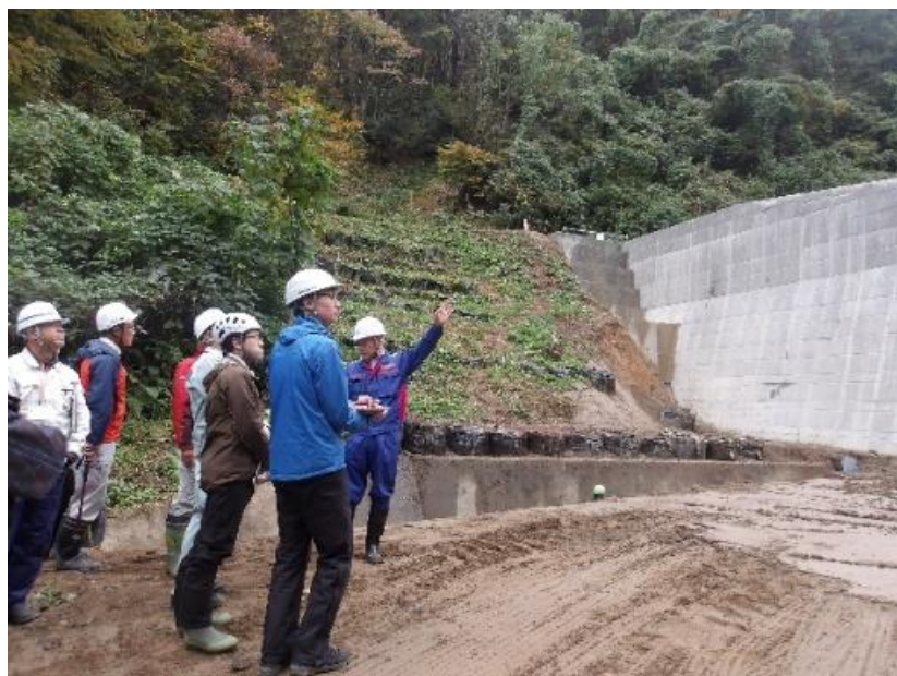
下土沢砂防堰堤の効果事例を説明
