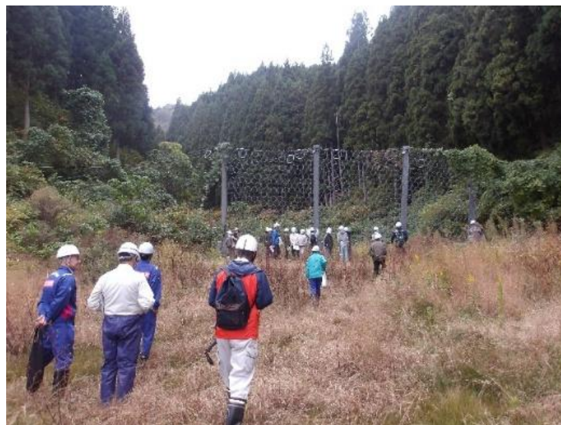
下土沢砂防堰堤上流のワイヤーネットを見学
